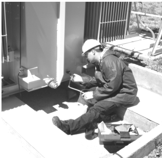
Fig. 10.6.5: Extracción de aceite para ensayo cromatográfico
