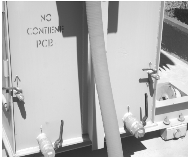
Fig. 10.6.3: Robinetes para extracción de muestras de aceite
