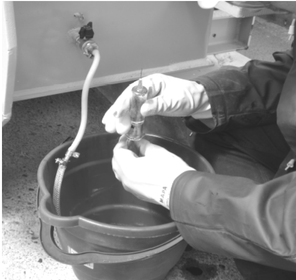
Fig. 10.6.4: Preparación de la extracción de aceite
